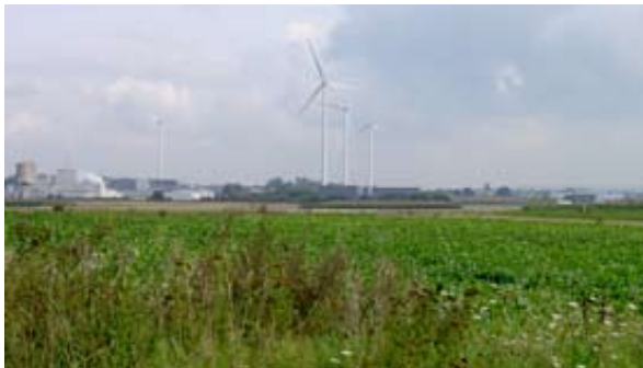
Bestaande windmolens op Belgische bedrijventerrein, zicht vanaf het Albertkanaal.
